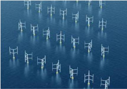
La Universidad de Oxford Brookes ha investigado el diseño de las turbinas verticales y defiende que son más eficientes que las tradicionales en los parques eólicos a gran escala, y que cuando se colocan por parejas, las turbinas verticales aumentan el rendimiento de las demás hasta en un 15%.
