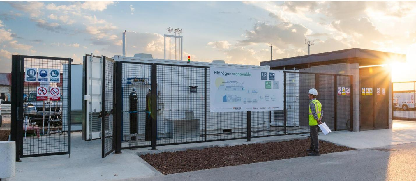
En el proyecto H2Vert, se utiliza agua de la red de la sede y electricidad de placas solares para generar hidrógeno mediante la electrólisis. Utiliza un electrolizador de 10kW con un 70% de eficiencia.
