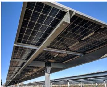
La Universidad Politécnica de Madrid, la empresa PVH y el Instituto de Energía Solar, colaboran en la elaboración de un análisis sobre las irradiancias frontal y posterior de los módulos bifaciales, la potencia de las células y sus temperaturas de operación, para saber el efecto de estas dos a la productividad del sistema.
