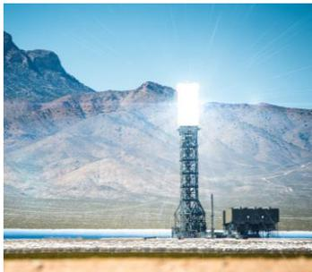
Acciona impulsa el proyecto Photon para centrales solares de torre central, con el fin de mejorar su eficiencia entre un 10% y un 15%, con instalaciones de potencia nominal entre los 50MW y 150MW. Se estudia el uso de heliostatos con un sistema híbrido solar-fotovoltaico inalámbrico, para que puedan calibrarse automáticamente mediante el uso de la propia energía generada por cada uno de ellos.
