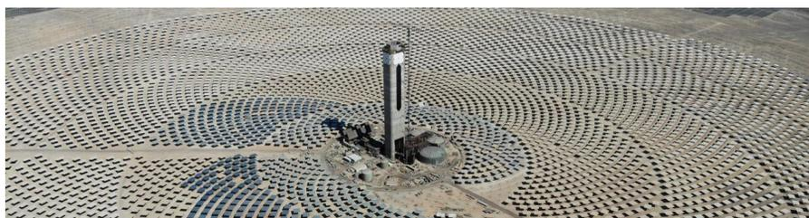
Las sales producidas por la minera SQM y que usará el pionero proyecto termosolar Cerro Dominador, en Chile, tienen la capacidad de conservar la energía captada en el día por la planta y mantenerla, en un sistema de almacenamiento en tanques, durante las 24 horas del día aportando gran flexibilidad al sistema eléctrico. Estas sales se mantienen a altísimas temperaturas: 560° celsius en el caso de los tanques calientes y 290° en el caso del tanque de sales frías.
