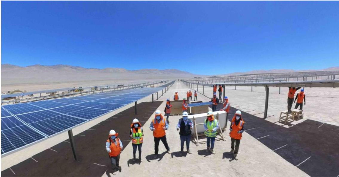
La Planta Solar Capricornio (ubicado a 35 km de la ciudad de Antofagasta) está con un 85% de avance global. Cuenta con 88 MWac de capacidad instalada y considera la utilización de 249.210 paneles solares. A la fecha, entre sus principales hitos se pueden destacar la instalación de su transformador principal y la finalización del edificio de control de Obra Civil.
